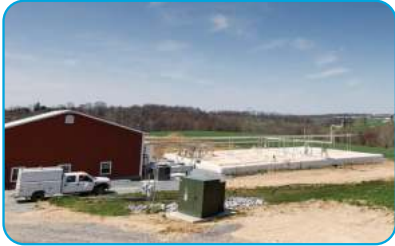
Digestor de metano
